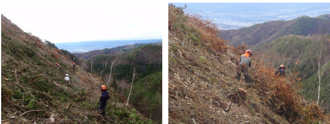
写真 5-5-9 地拵えの状況
