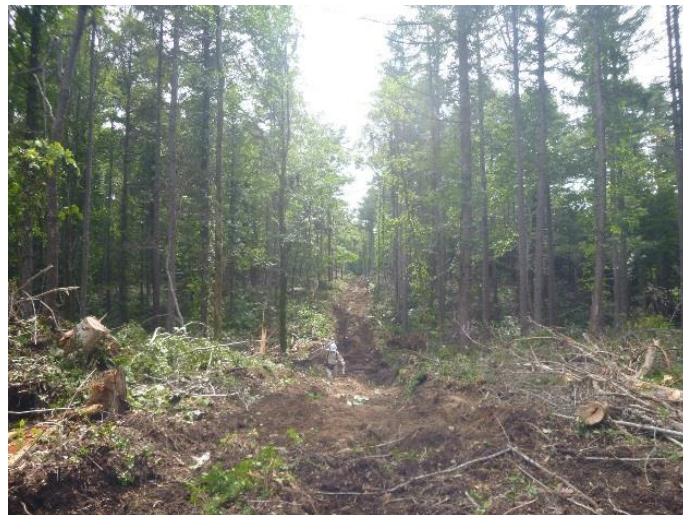
写真 5-3-2 作業道開設状況
