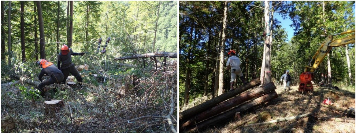
写真 5-5-4 斜面下部での作業状況（左）、斜面上部での作業状況（右）
