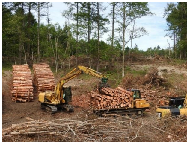
写真 5-3-7 グラップルによる積み下ろし・巻立て
