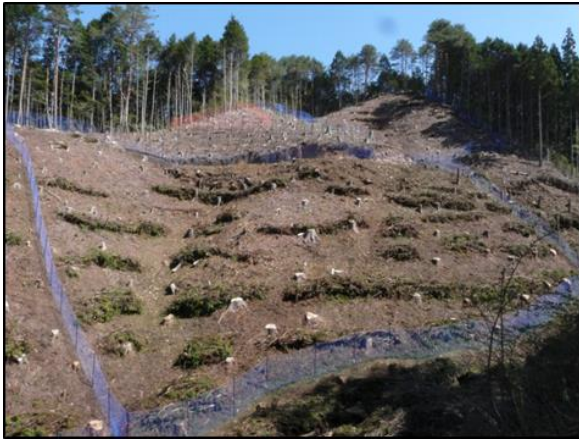
写真 4-3-14 植栽作業完了後の植栽地の状況
