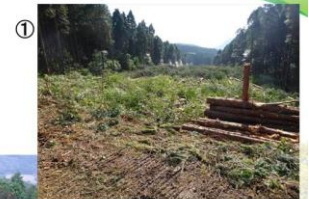
②林道や作業道へ伐倒方向を調整
