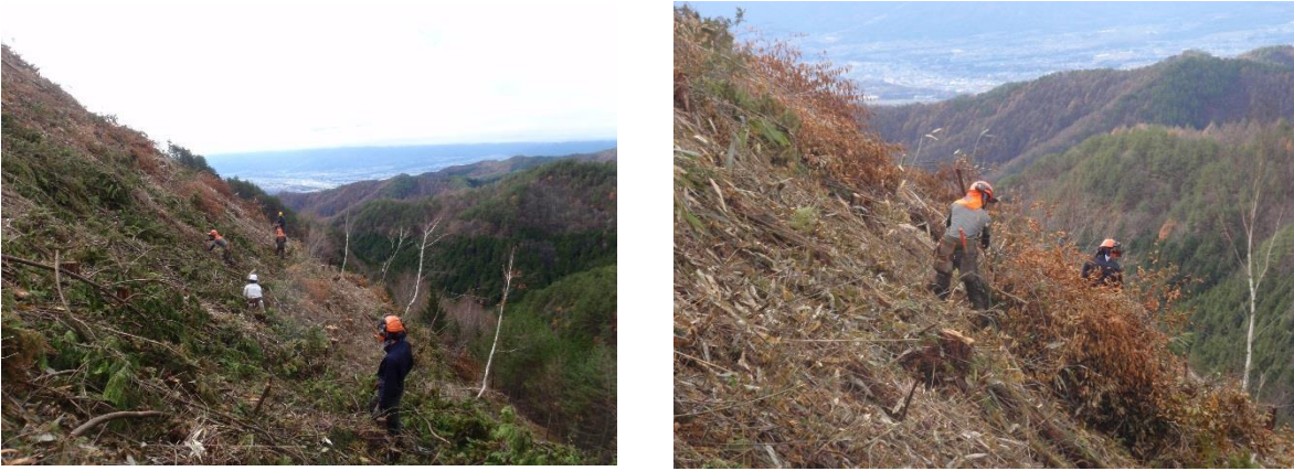
写真 4.13 平成 27 年の人力による地拵え作業(H27 年度報告書より)
