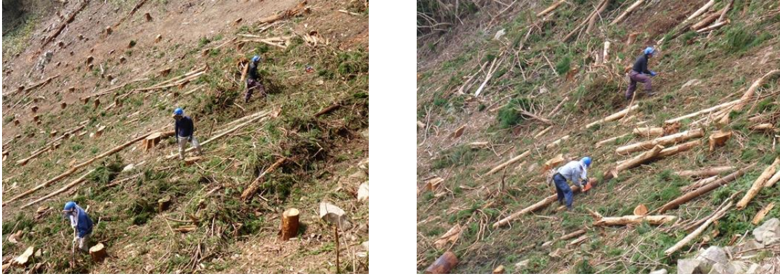
写真 4.20 草刈り鎌やチェーンソーを用いた地拵えの状況
