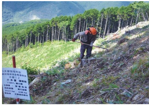
写真 4.16 地拵えの状況 (H25 年 8 月)
