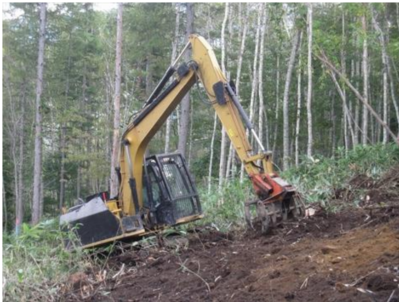
写真 4.6 グラップルレーキによる全刈の地拵え状況（H27 年 9 月中旬）
