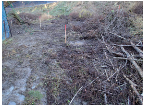
写真 17 No.1-④愛知県豊田市水田跡地 (排水路なし：田内)
