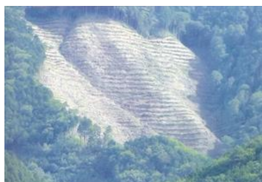
⑥地拵え後の全景
