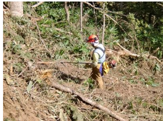
④大型機械処理が不適な箇所を中心に、刈払機による人力仕上げ
