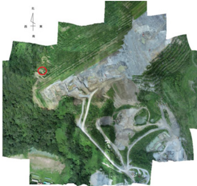
図 7-4 荒廃地等への緑化の実証地全景
