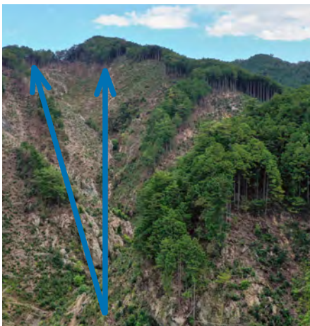
荷下ろし地点の俯瞰
