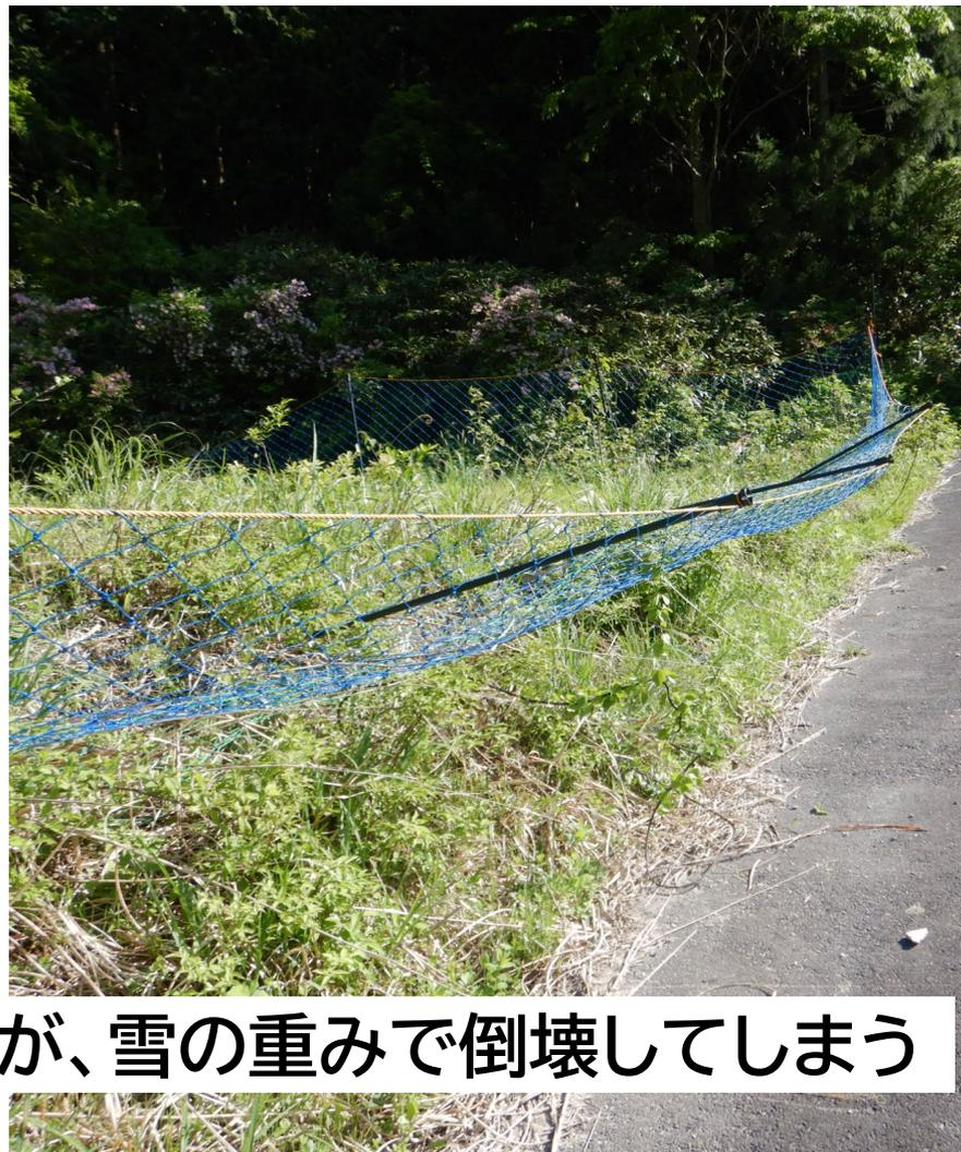
ネット柵(耐雪仕様)を設置するが、雪の重みで倒壊してしまう
