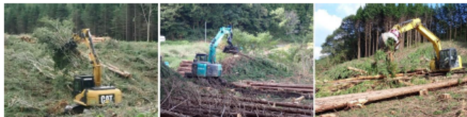
図3 機械による地植えの事例
