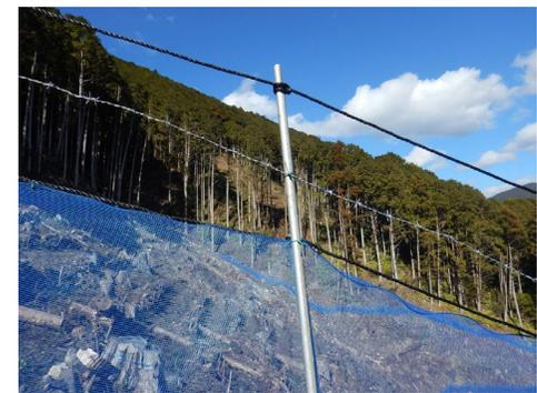
ロープと有刺鉄線の設置により飛び込みを防止
