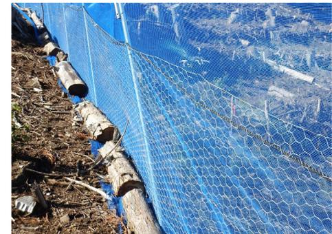
亀甲金網の設置により食い破りを防止
