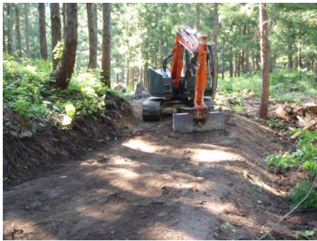
森林作業道 開設
