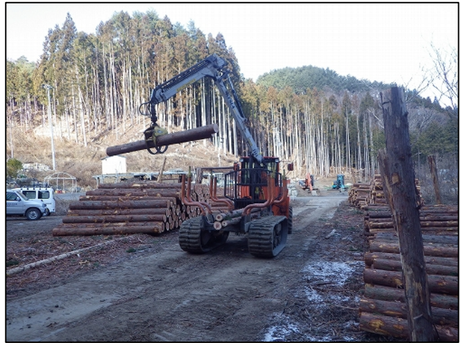
新型フォワーダによる搬出・巻立状況
