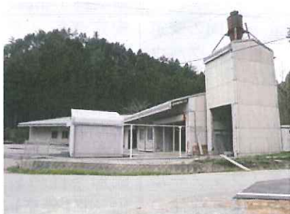
写真1 プラント設置場所全体
