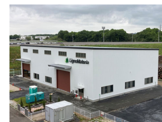
実証プラント
