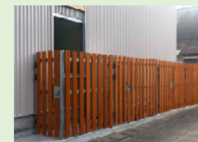
外壁フェンス CNF含有の下塗り塗料により、紫外線の透過を抑制し、木材の変色や劣化を防ぐ 写真:玄々化学工業株式会社
