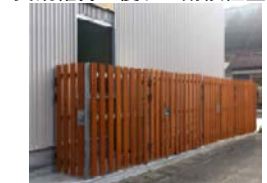
四国森林管理局 嶺北森林管理署外壁フェンス
