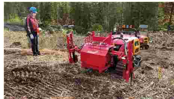
遠隔操縦式植栽用穿孔機による穿孔作業
