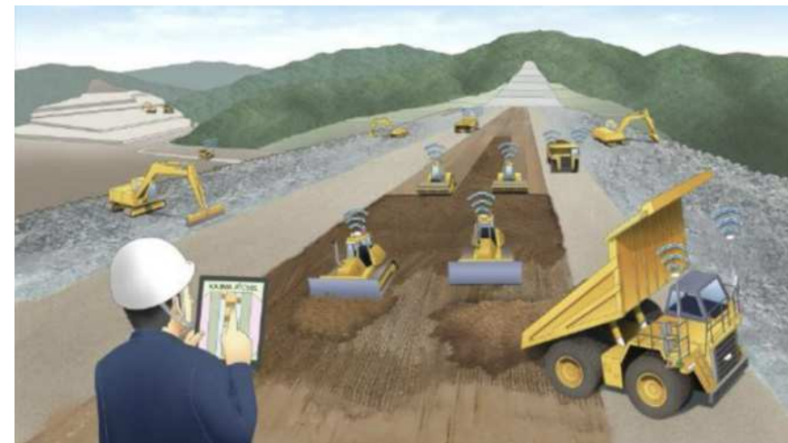
出所：鹿島建設㈱ 建設機械の自動化システム「A4CSEL®」に自動ダンプトラックを導入 https://www.kajima.co.jp/news/press/201701/11c1-j.htm
