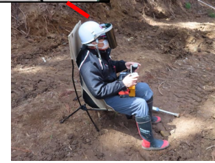
①AR技術を活用した遠隔操作
