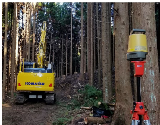
作業道の開設
