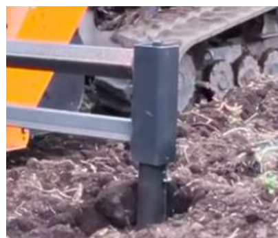
自重打込杭方式
