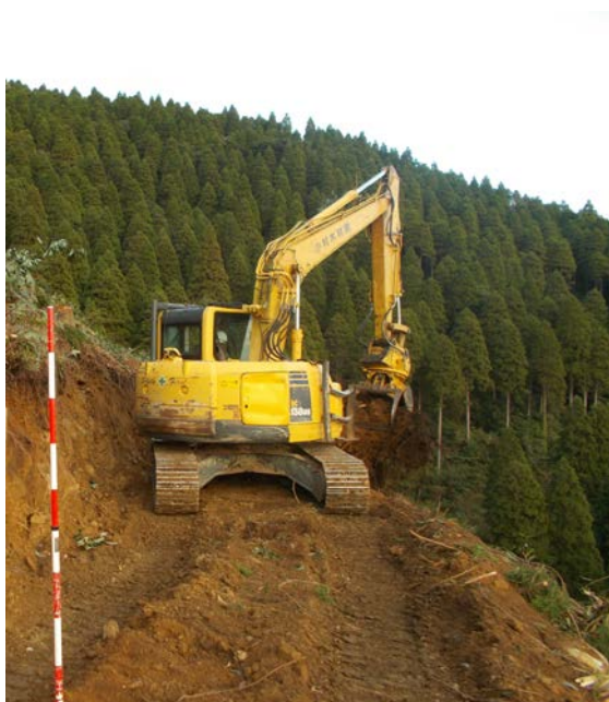
【グラップルバケットによる作業道開設】
