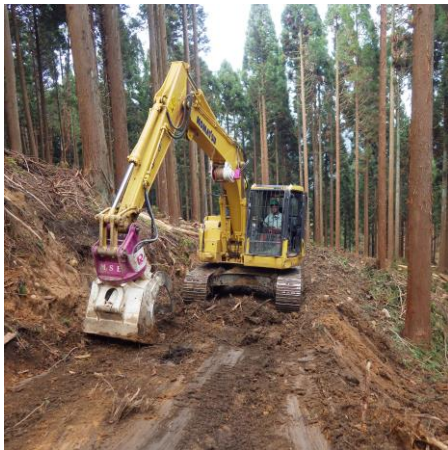
【フォーク収納型グラップルバケットによる作業道作設】
