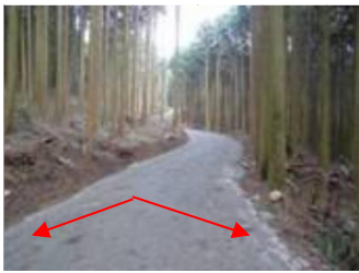
写真1 完成写真（凸型路面）
