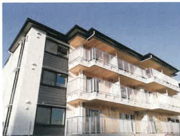
[写真 7-10] CLT パネル工法により建設された復興公営住宅 資料：林野庁「平成 29 年度森林・林業白書」
