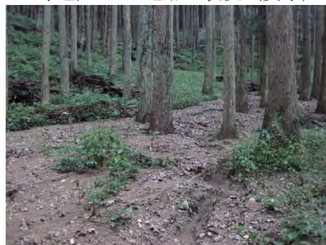
立野地区 67-9 地点周辺の被害状況
