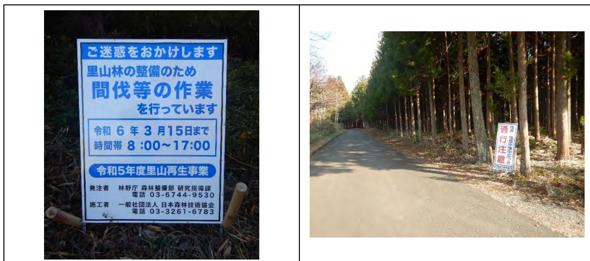
写真 1-1 事業工事看板の設置の様子
