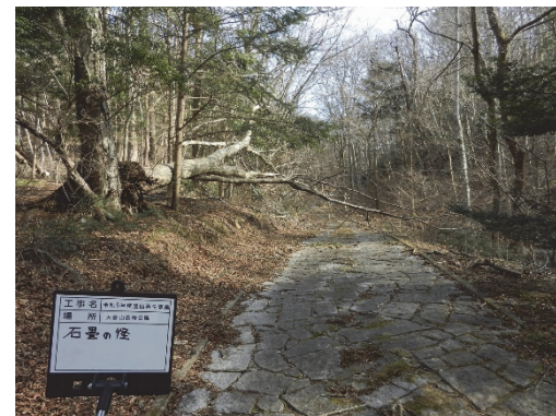
遊歩道の状況
