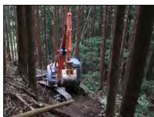
森林作業道作設
