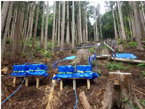
設置状況全景
