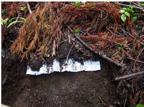
メッキ鋼板打ち込み状況
