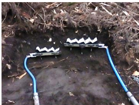
設置状況(近景)
