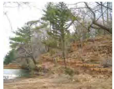
丸太筋工の設置
