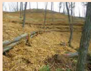
丸太筋工の設置
