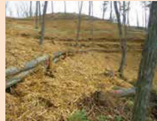
丸太筋工の設置
