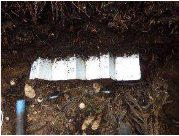
メッキ鋼板打ち込み状況
