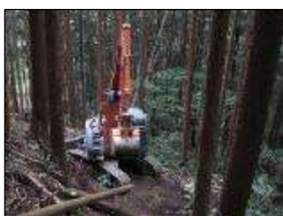
森林作業道作設
