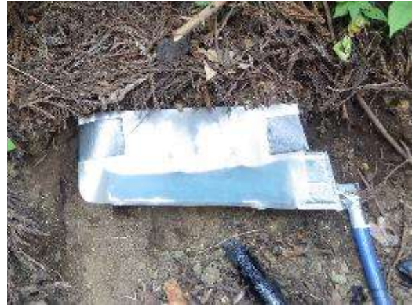
トタン水受けと3Dプリンタで作成した 連結部品を設置
