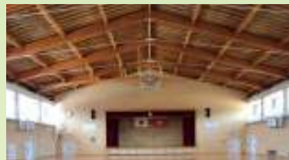
●福島市立渡利中学校屋内運動場
