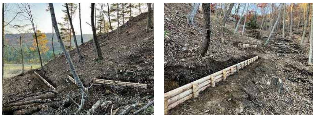
写真 4.32 丸太筋工の設置状況
