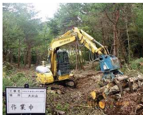
重機による集積整理
