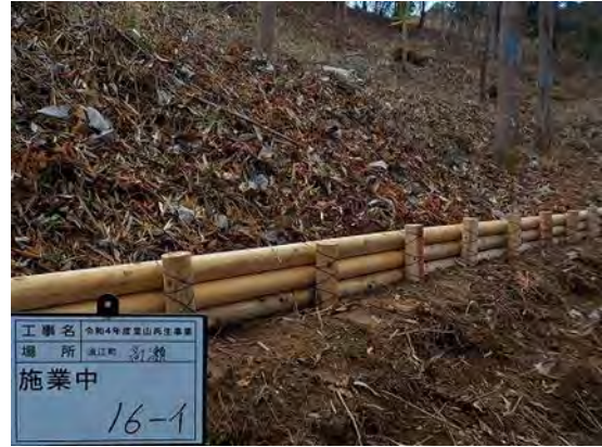
写真 3-5-3-1 丸太筋工設置状況
