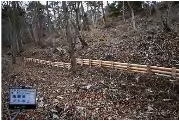
写真 3-5-3-1 丸太筋工設置状況
