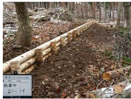
写真 3-2-3-1 丸太筋工設置状況
