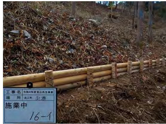
写真 3-5-3-1 丸太筋工設置状況
