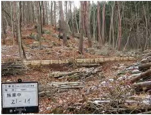
写真 3-2-3-1 丸太筋工設置状況
