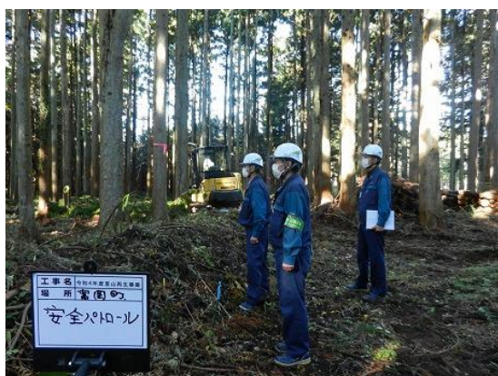
写真 1-6-3 安全パトロール
