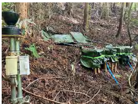
設置状況全景
