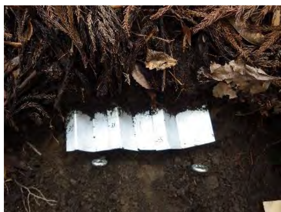
メッキ鋼板打ち込み状況
