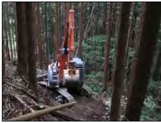
森林作業道作設
