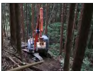
森林作業道作設
