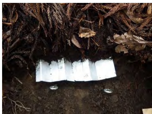
メッキ鋼板打ち込み状況
