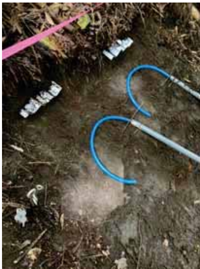
メッキ鋼板打ち込み完了
