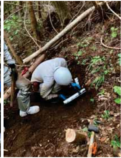
メッキ鋼板打ち込み状況
