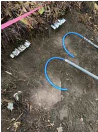
メッキ鋼板打ち込み完了
