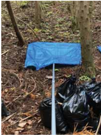
設置斜面保護状況
