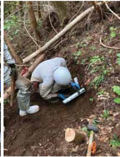
メッキ鋼板打ち込み状況
