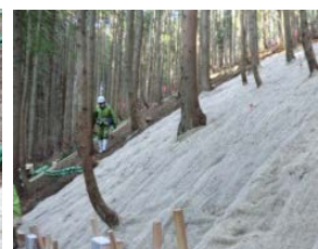
植生シート工
