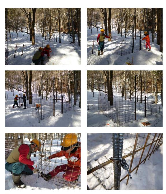
写真 4-5 簡易囲いわなの設置工程 幅 1m のユニットを 1 枚ずつ番線でつないでいく
