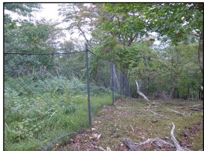
防護柵の設置
