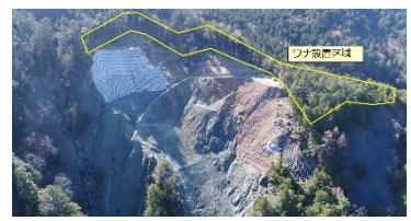
治山工事箇所周辺のワナ設置区域
