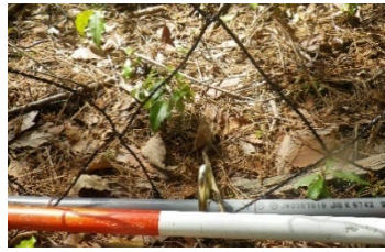
○ネットと塩ビパイプをアンカーピンで固定
