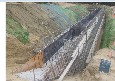
レールに沿って型枠や足場を上昇させることができるスライド型枠を採用
