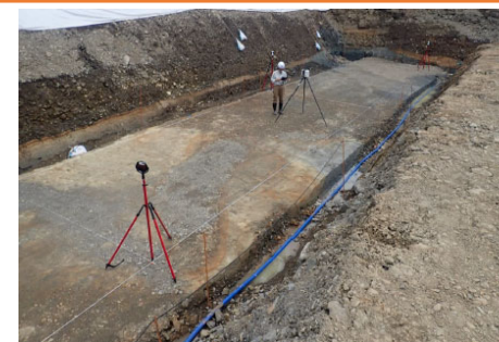
地上レーザースキャナーを用いた3次元出来形管理
